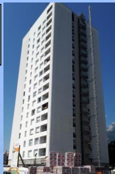
2019 – 3 Tours 72-74-76 Réhabilitation thermique 199 logements
