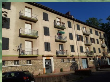
2019 - Démolition Barettes DRAC
