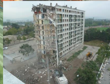
2009 – Barres Straus Démolition 5 bâtiments
