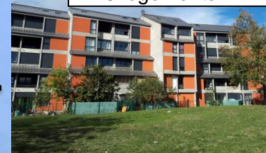
2019 - Lys Rouge Réhabilitation thermique 125 logements
