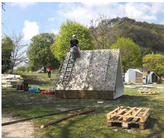
Installation des cabanes de bivouac sur le site sommital de La Bastille, conçues par les étudiants de l'École d'architecture de Grenoble - ENSAG dans le cadre de l'année Capitale Verte. Le 15 avril 2022. © Aurianne Poillet / Ville de Grenoble
