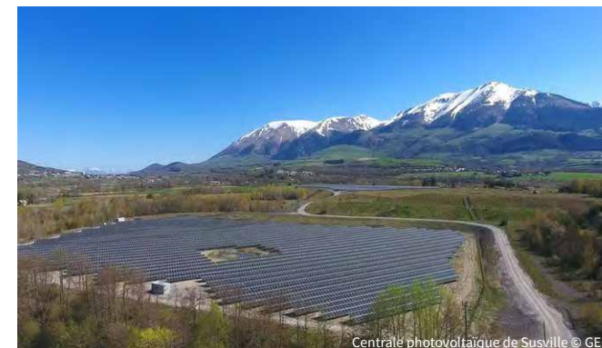
Centrale photovoltaïque de Susville © GEG
